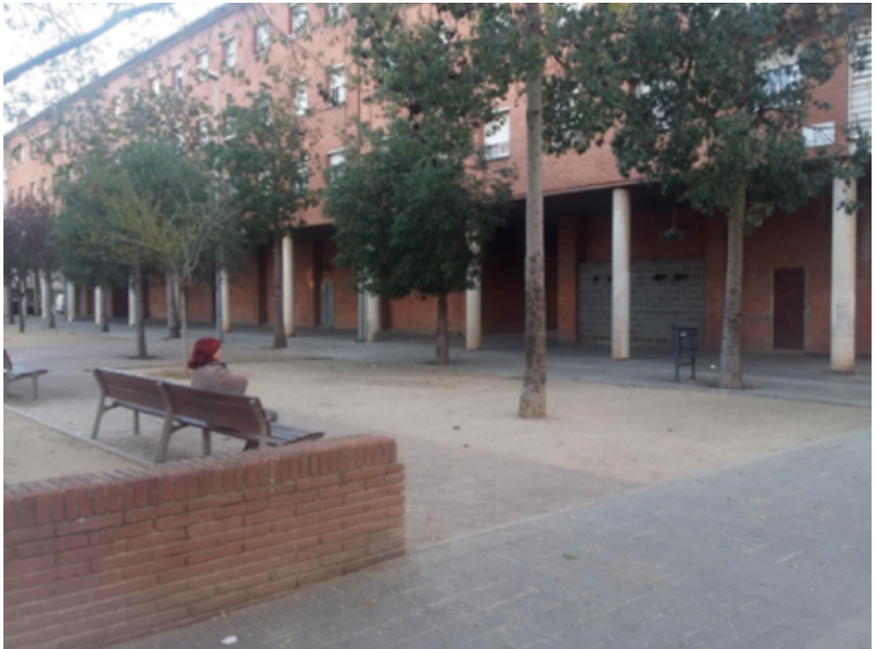
Imatge d'un dels locals en desús al carrer Quito.
